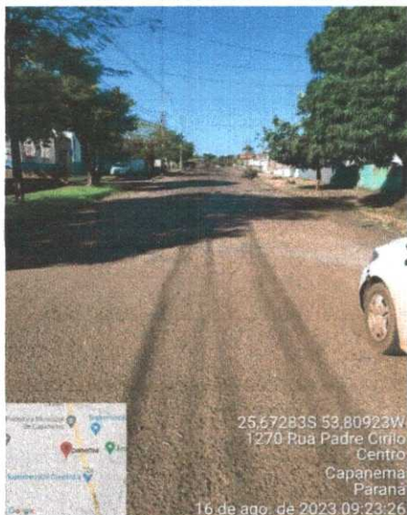
FOTO 05- Início do Trecho da Rua Padre Cirilo, cruzamento com a Rua Rio de Janeiro.
